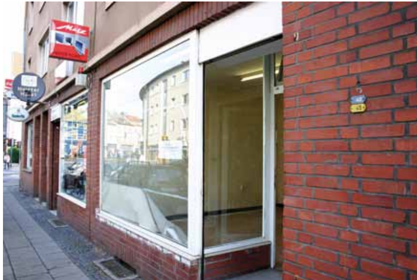
Wohn- und Geschäftshaus Rellinghauser Straße 277
